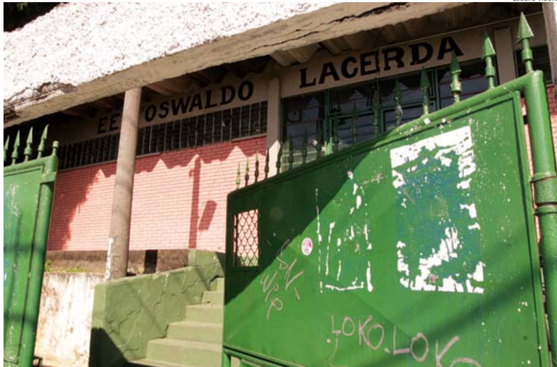
EE Oswaldo Cardim, em Diadema, sofre com a falta de estrutura e teve péssima nota no Idesp
