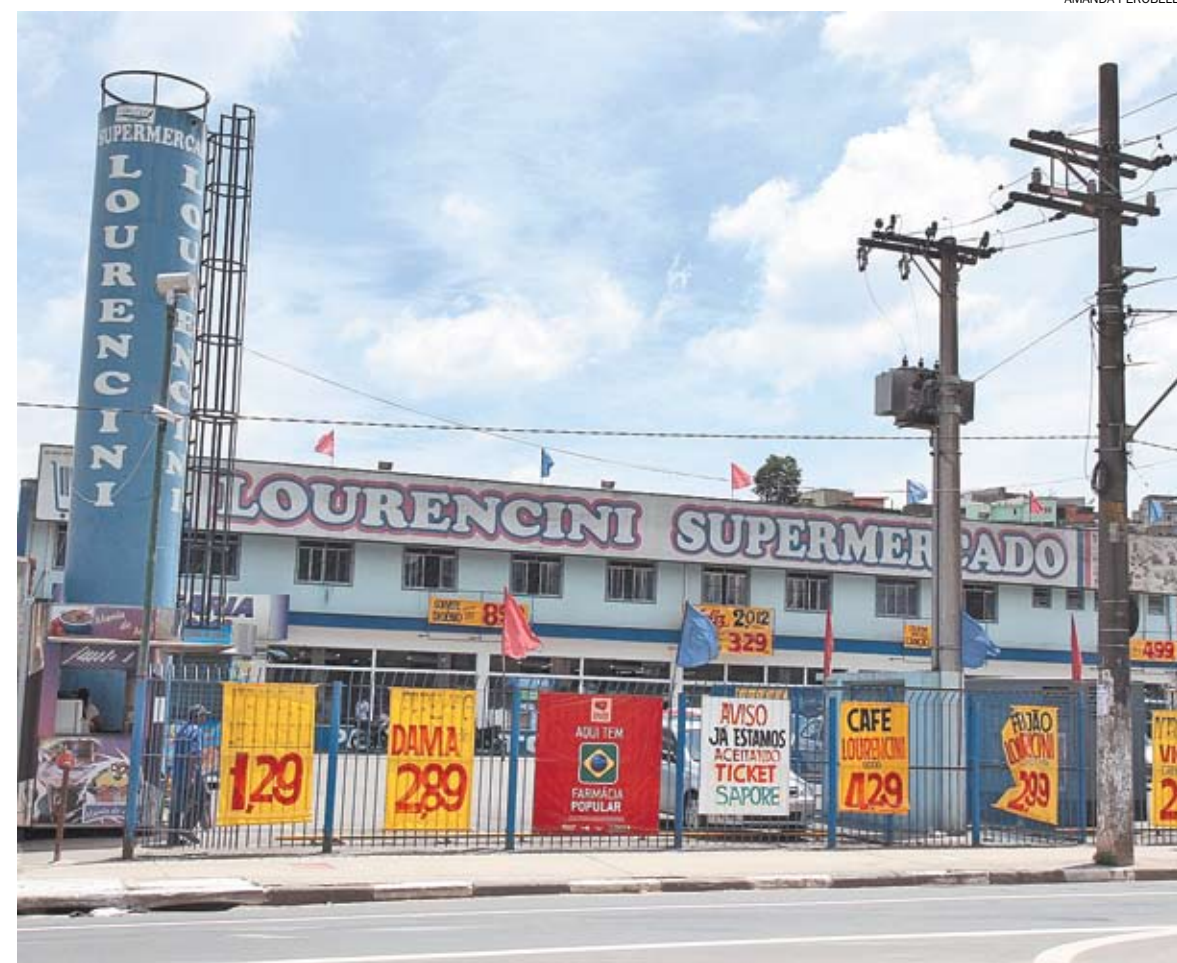
Supermercado Lourencini está construído em área de preservação permanente; dono não foi localizado para comentar assunto
