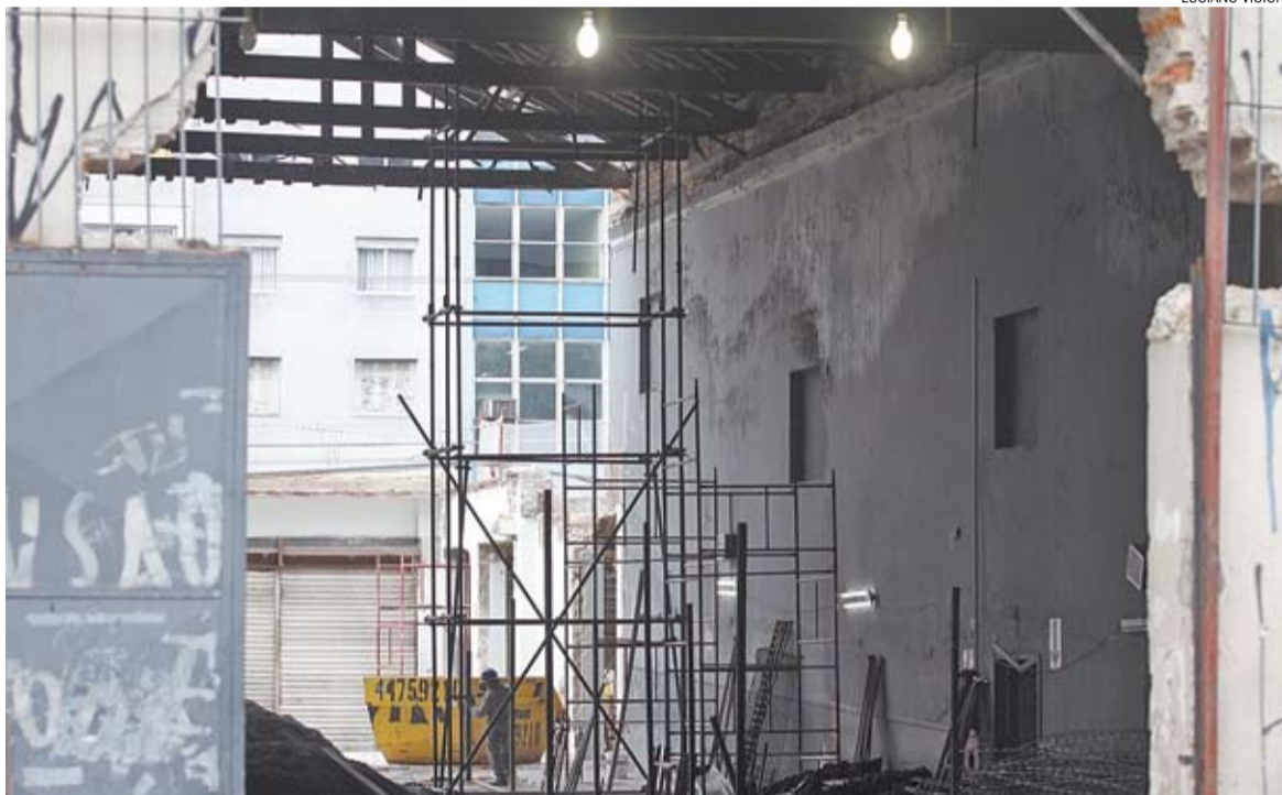
Forro onde havia estrela que não poderia ser retirada foi destruído durante as obras de restauração
