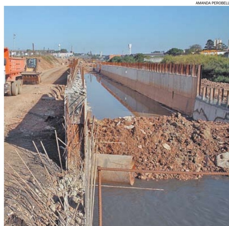
Obras incluem nova via que vai ligar a avenida Piraporinha ao Corredor ABD
