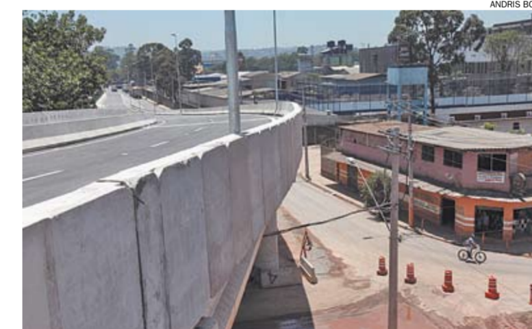
Trecho da fase entregue passa sobre a linha férrea em Capuava
