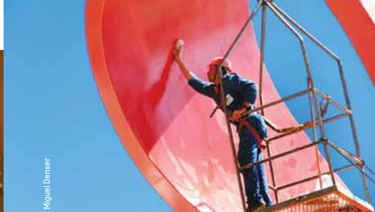
Operário faz manutenção e limpeza no Monumento ao Trabalhador
