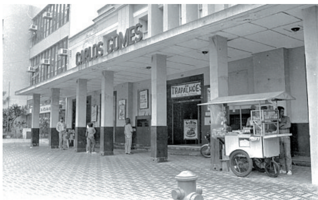
Cine Carlos Gomes poderia novamente abrigar filmes, mas espera há tempos por reforma adequada
