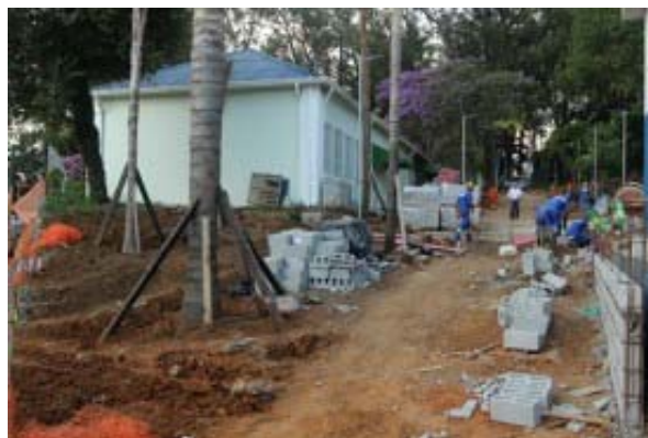
Parque passou por obras e será entregue totalmente revitalizado. Foto: Rodrigo Pinto
