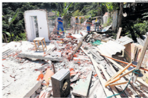
NO CHÃO. Pelo menos seis casas foram derrubadas e outras 30 devem ser retiradas nos próximos dias
